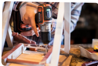
5. Grâce à des petites équerres, le morceau de bois rectangulaire est fixé au bas du tabouret. Un coup de ponçage, et c'est presque terminé!
